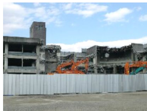
↑ 旧山梨市庁舎の取り壊しが始まる 跡地の活用が課題
