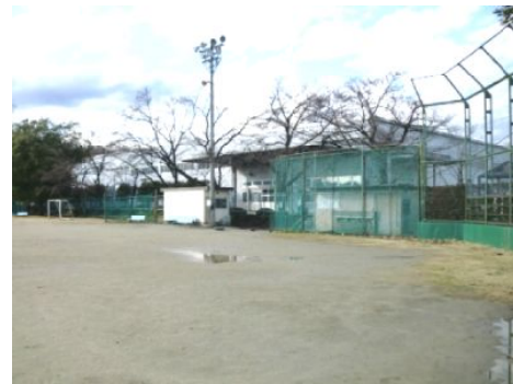
↑「南棟」を撤去してグラウンドの拡張を行う
